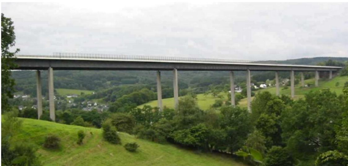
Abb.: Wiehthalbrücke auf der A 4
